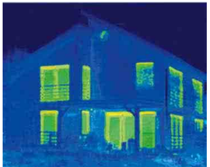
Thermografie nach dem Einbau neuer Schüco Thermo 6 Energiesparfenster
